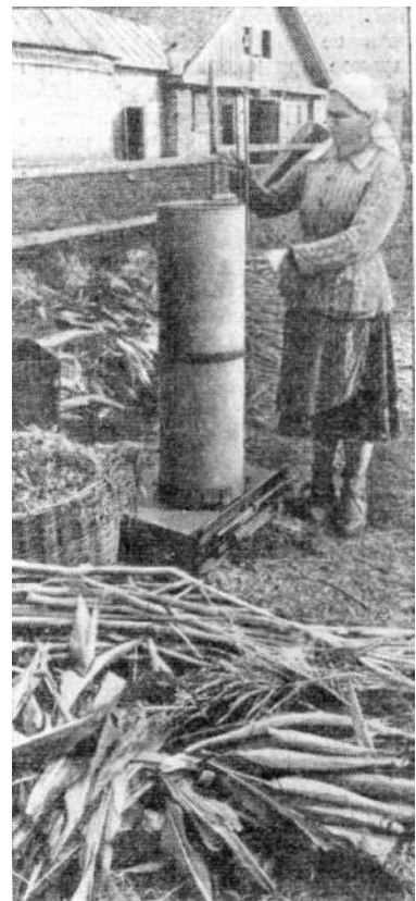
Работница экспериментальной базы Всесоюзного института сельскохозяйственного машиностроения (ВИСХОМ) А. М. Шабанова определяет с помощью специальной аппаратуры объемный вес силосной массы кукурузы.
