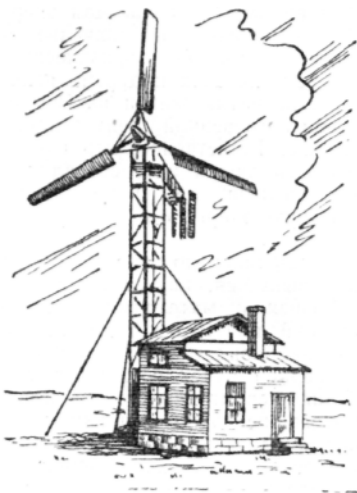
Ветроэлектростанция Д-18 мощностью до 25 киловатт.
